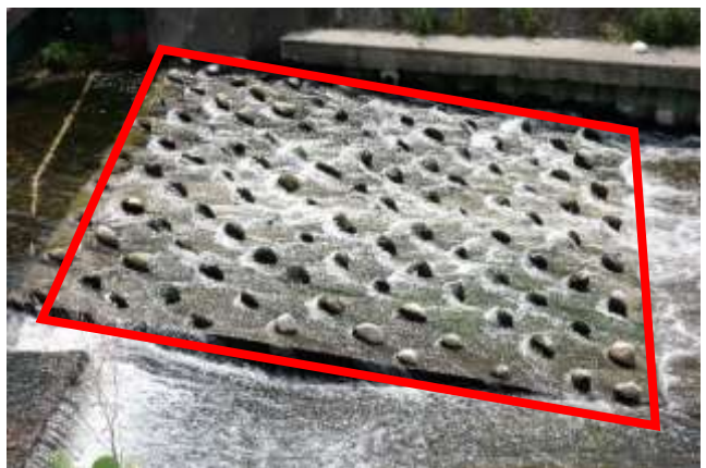
大鳥井堰撤去後の整備状況（赤枠は今回の改良、青枠は未改良）
