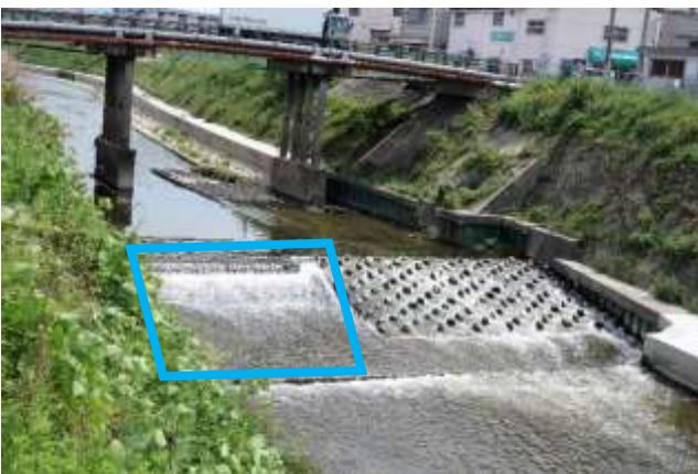
大鳥井堰撤去後の整備状況（赤枠は今回の改良、青枠は未改良）
