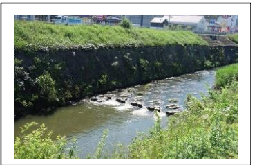
NO15 落差工（ブロック）
