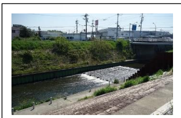
NO4 落差工（ブロック）
